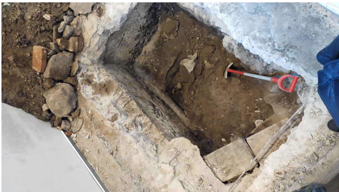
1. Odkrywki fundamentów w miejscu posadowienia dźwigu, 11.2021 r.
